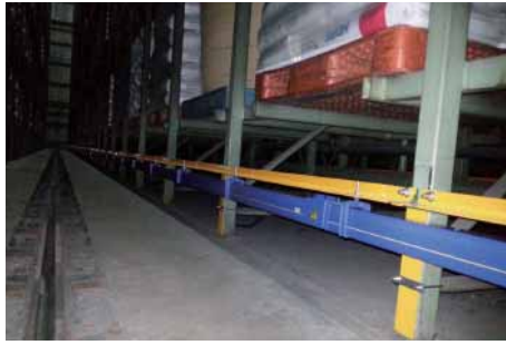
자동창고 스택커 크레인 Automatic warehousing stacker crane
