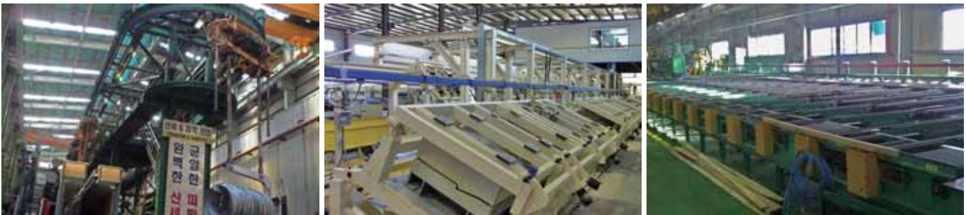
산처리 설비의 크레인 Hoist of acid and processing
